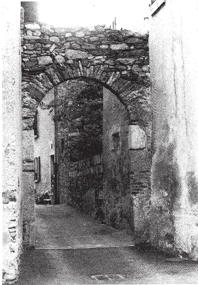
Uno dei due antichi portoni d'entrata nell'abitato di Rovello.
