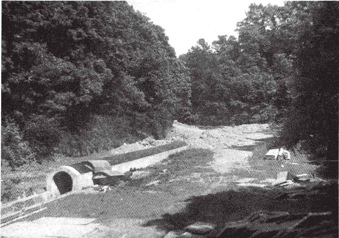
Un tratto della Val Gersa col cunicolo in costruzione prima del colmataggio e della conseguente creazione del Centro sportivo.
